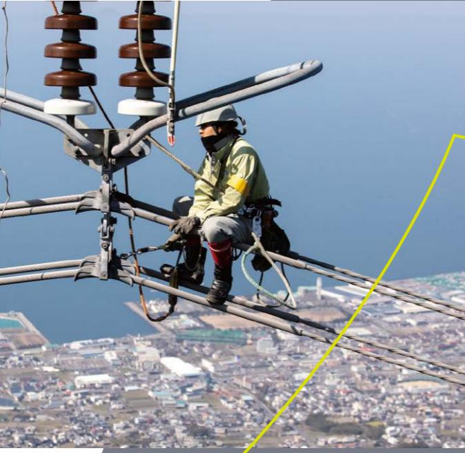
鉄塔と鉄塔の間に電線を張る仕事を「架線工事」といいます。架線工事では、まず細いロープを張ってから、細いワイヤー、太いワイヤーへと替えていき、最後に電線へと引き替えます。
